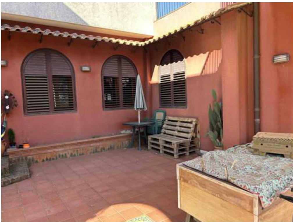
Foto n° 35 – Altra foto scattata alla pavimentazione sotto il portico in clinker. Le pareti esterne del fabbricato presentano un rivestimento a cappotto, con soprastante rete, rasante e tonachina.
