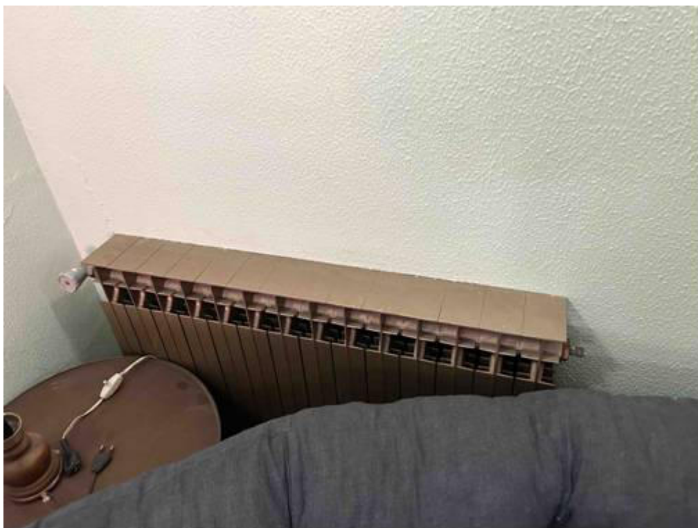
Foto n° 100 – Altra foto scattata al radiatore in alluminio pre-verniciato dell'impianto termico. L'impianto termico risulta sottotraccia ed a norma.
