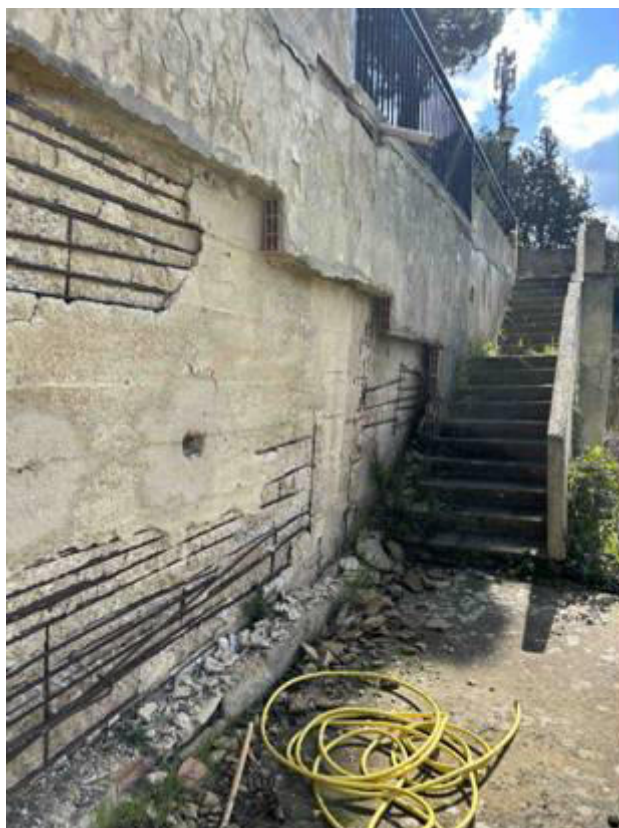
Foto n° 25 – Altra foto scattata al muro di contenimento realizzato al di sotto del piano sottostrada. Si rileva il crollo della parete in laterizio che rivestiva il muro per effetto della rotazione del muro nella parte sommitale.
