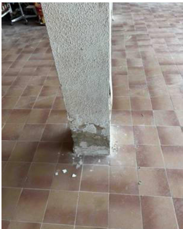
Foto n° 153 – Foto scattata ad uno dei pilastri centrali del portico. Si rilevano tracce di umidità di risalita lungo il pilastro. L'umidità ha sicuramente determinato l'ossidazione del ferro e determinerà anche il distacco del copriferro.
