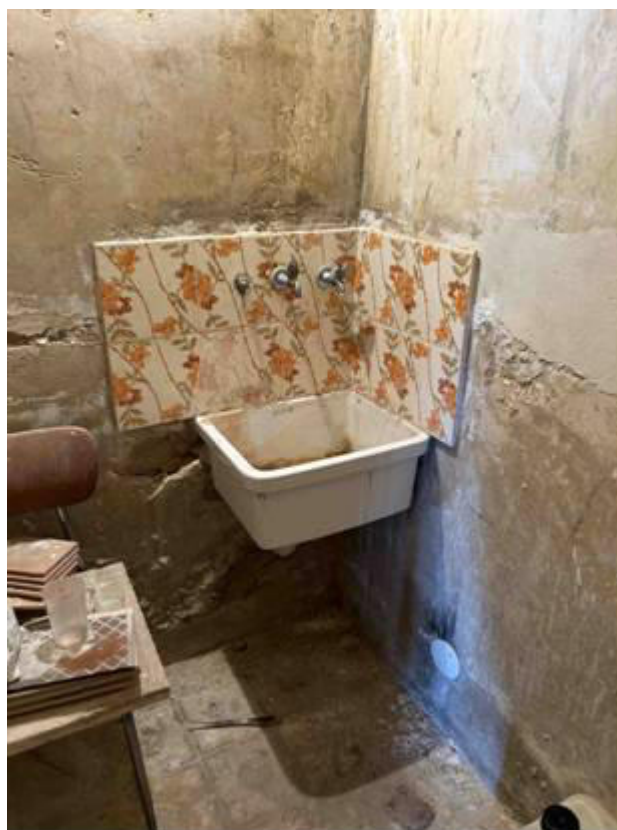
Foto n° 162 – Foto scattata alla pilozza collocata nel vano sottoscala. Si rilevano dei rubinetti singoli per l'acqua ed uno scarico per acque bianche.
