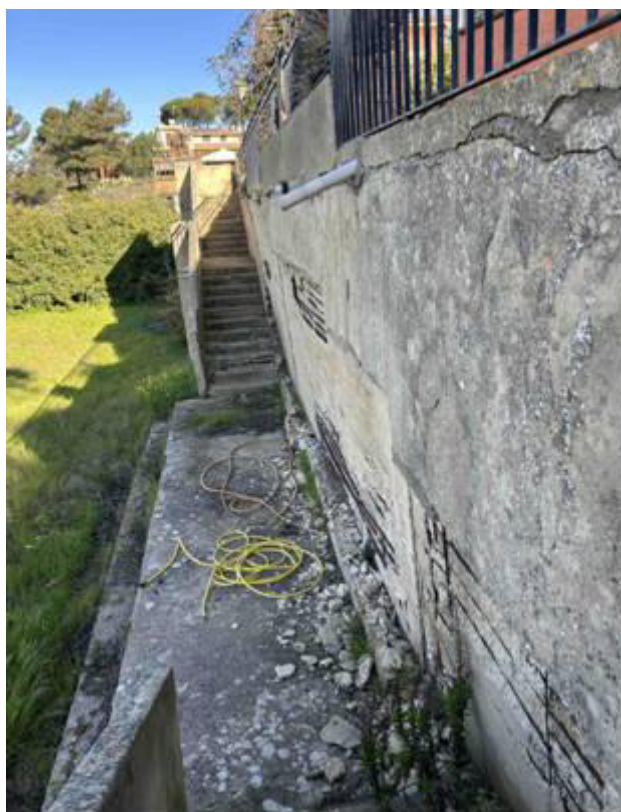
Foto n° 21 – Foto scattata dalla scala in cemento armato che consente l'accesso alla porzione di terreno posta al di sotto del piano sottostrada. Il muro di contenimento presenta in alcuni tratti il distacco del copriferro.
