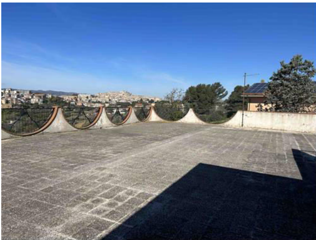
Foto n° 40 – Altra foto scattata al lastrico solare. La pavimentazione è in scaglie di granito mentre il parapetto è costituito da muratura intonacata e da ringhiera in ferro pieno. La parte sommitale ed inferiore del parapetto in cui poggia la ringhiera è rivestita con mattoni in clinker.
