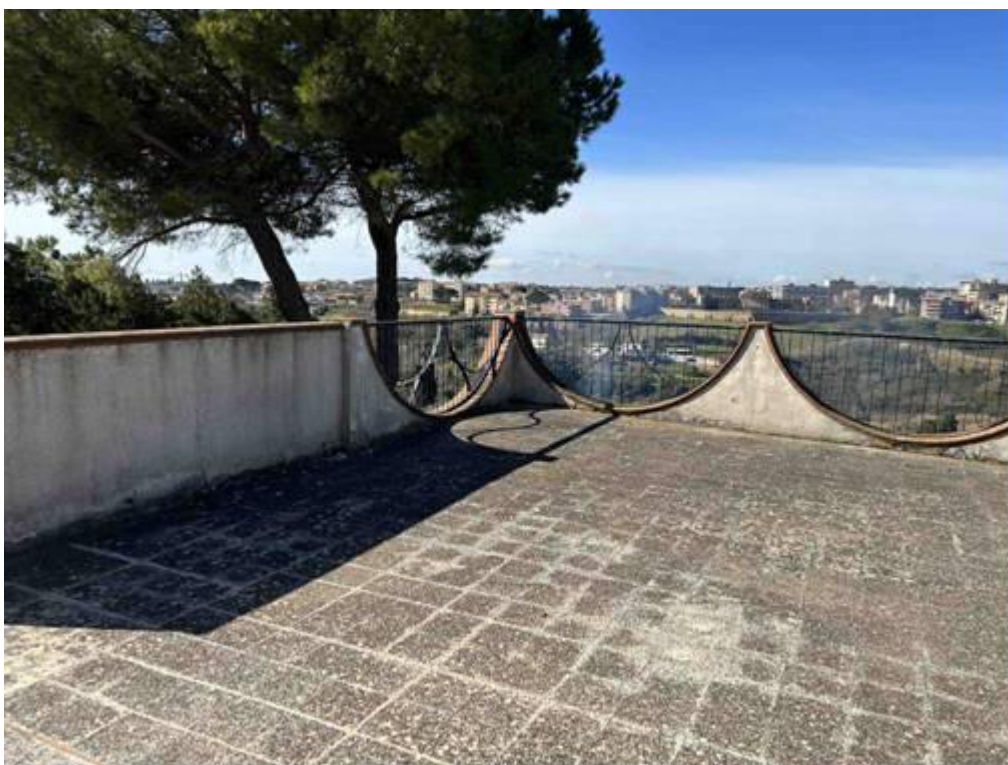
Foto n° 38 – Foto scattata al lastrico solare. La pavimentazione è in scaglie di granito mentre il parapetto è costituito da muratura intonacata e da ringhiera in ferro pieno. La parte sommitale ed inferiore del parapetto in cui poggia la ringhiera è rivestita con mattoni in clinker.
