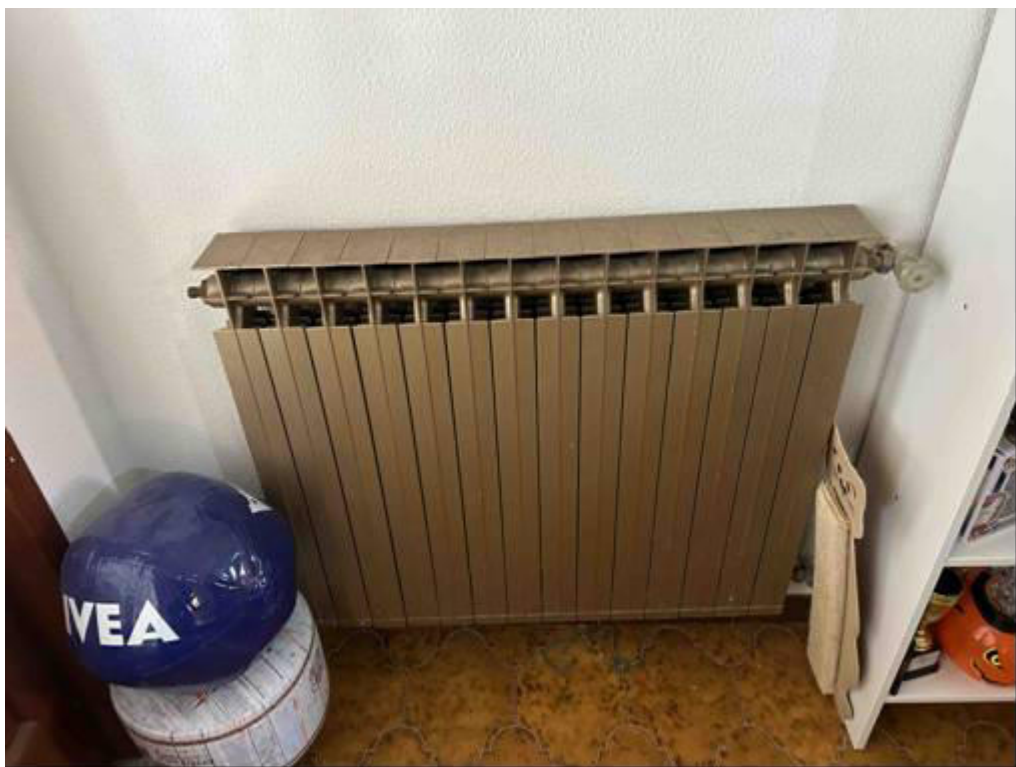
Foto n° 66 – Foto scattata al radiatore in alluminio pre-verniciato dell'impianto termico. L'impianto termico risulta sottotraccia ed a norma.
