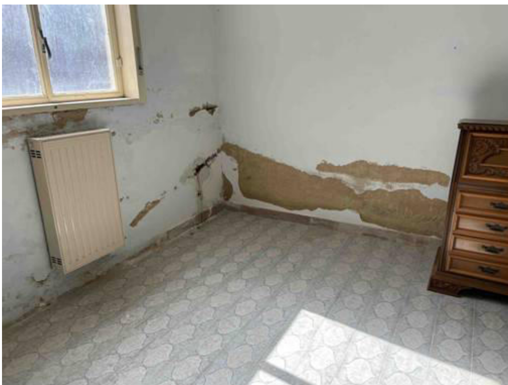
Foto n° 140 – Altra foto scattata alla pavimentazione ed alle pareti perimetrali. Si rilevano porzioni in cui è presente dell'umidità di risalita lungo le pareti perimetrali. E' inoltre presente un radiatore in alluminio pre-verniciato in discrete condizioni ed un infisso in lamiera a due ante.
