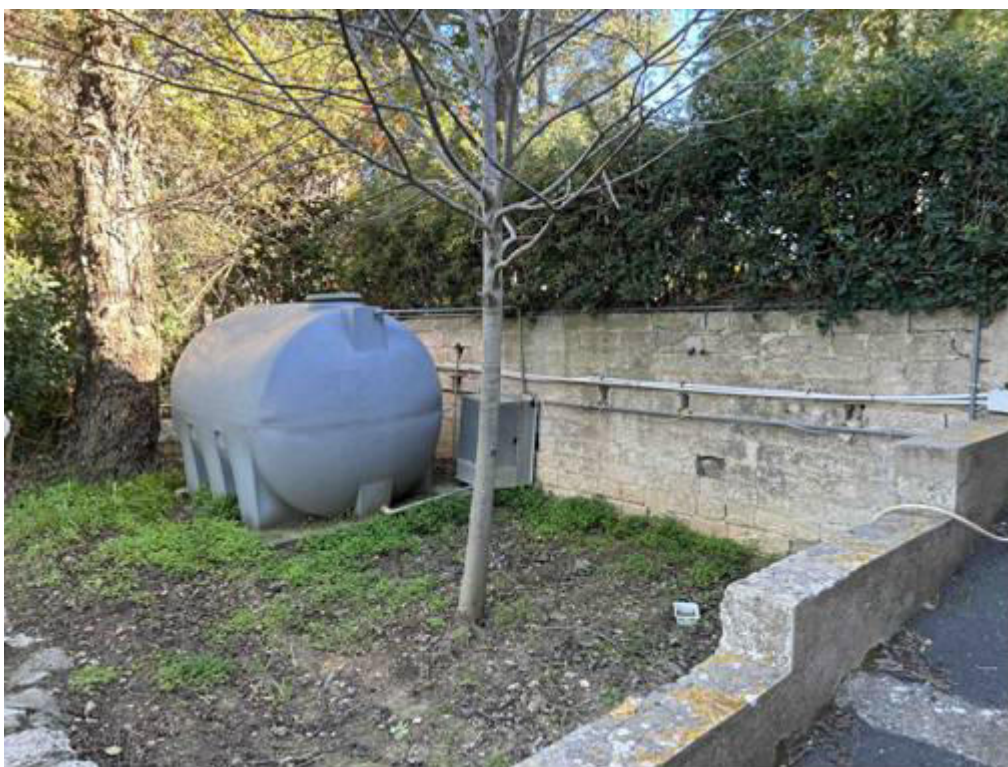
Foto n° 18 – Foto scattata al serbatoio in polietilene da 5000 litri, collegato tramite una pompa esterna all'abitazione.
