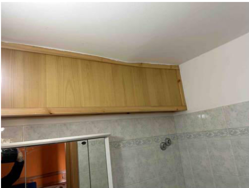
Foto n° 133 – Foto scattata al soffitto. Si rileva un condotto rivestito in legno dove all'interno sono transitano le tubazioni dell'impianto termico.
