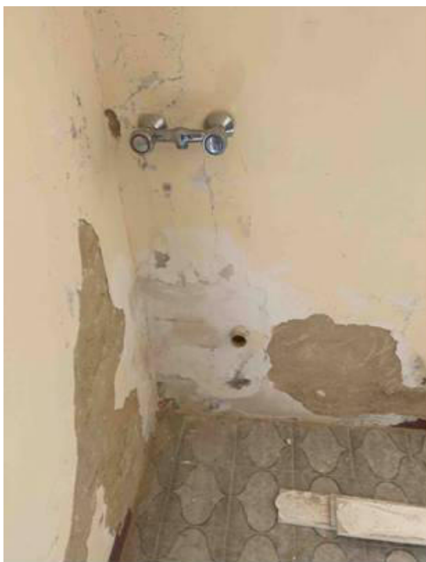
Foto n° 152 – Foto scattata nelle pareti del vano disimpegno in cui si rilevano le tracce di umidità di risalita. E' presente anche un gruppo miscelatore per lavello ed uno scarico per acque bianche.
