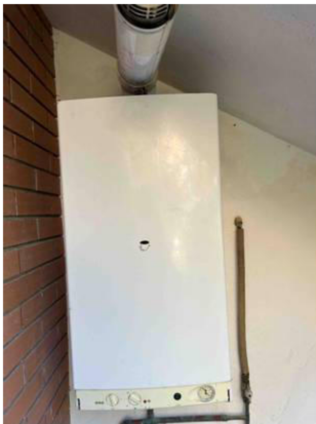
Foto n° 121 – Foto scattata alla caldaia a camera stagna installata nel sottoscala. La stessa risulta funzionante.
