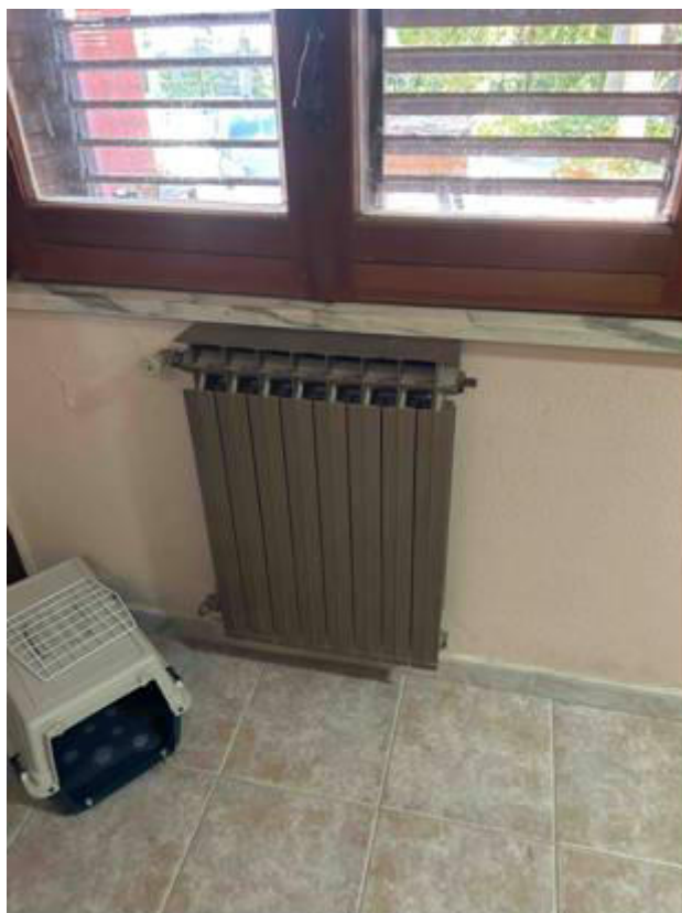
Foto n° 87 – Altra foto scattata al radiatore in alluminio pre-verniciato dell'impianto termico. L'impianto termico risulta sottotraccia ed a norma.
