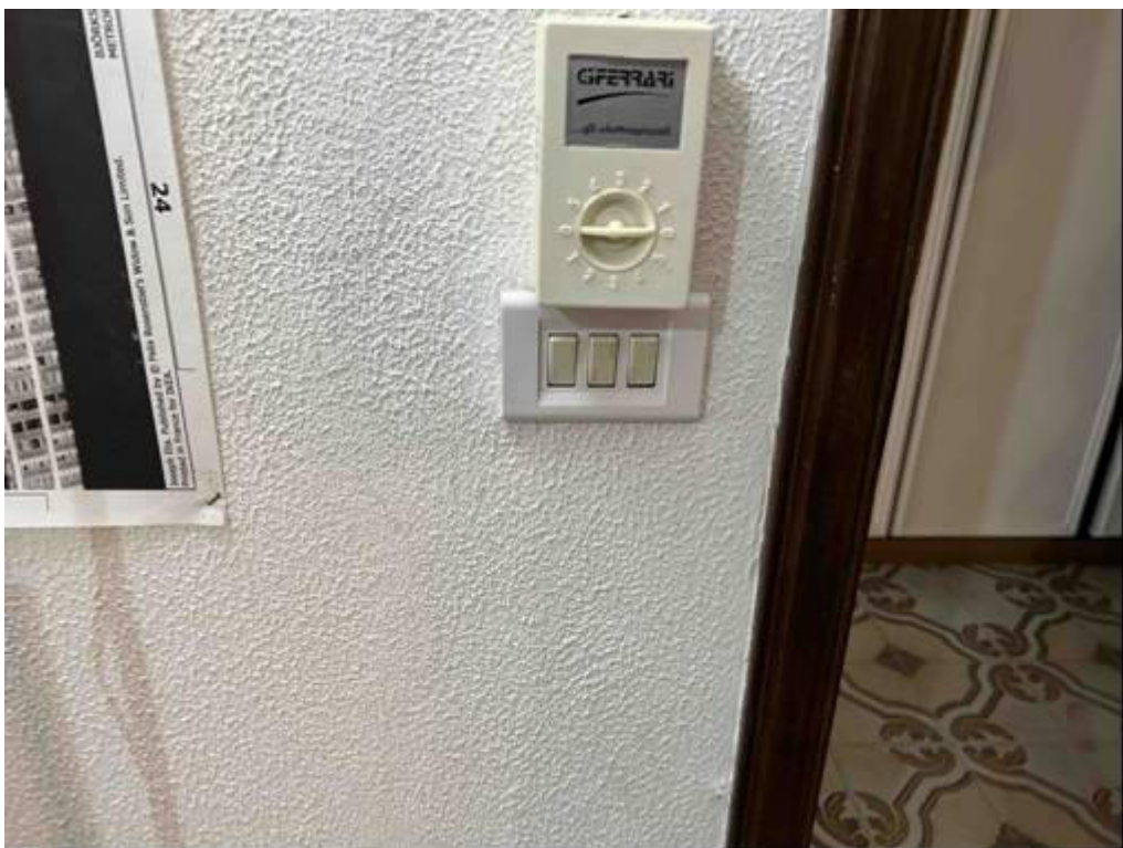
Foto n° 65 – Foto scattata ad una delle pareti rifinita con intonaco civile e tinteggiata con idropittura con effetto goccia. Foto scattata all'interruttore interno. L'impianto elettrico risulta sottotraccia ed a norma.
