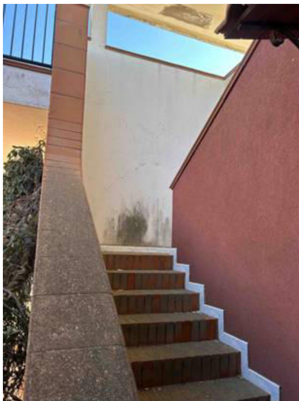
Foto n° 37 – Foto scattata alla scala che consente l'accesso al soprastante lastrico solare. Le pedate e le alzate della scala sono realizzate con mattoni in clinker. Le pareti esterne sono tutte intonacate e rifinite a tonachina.
