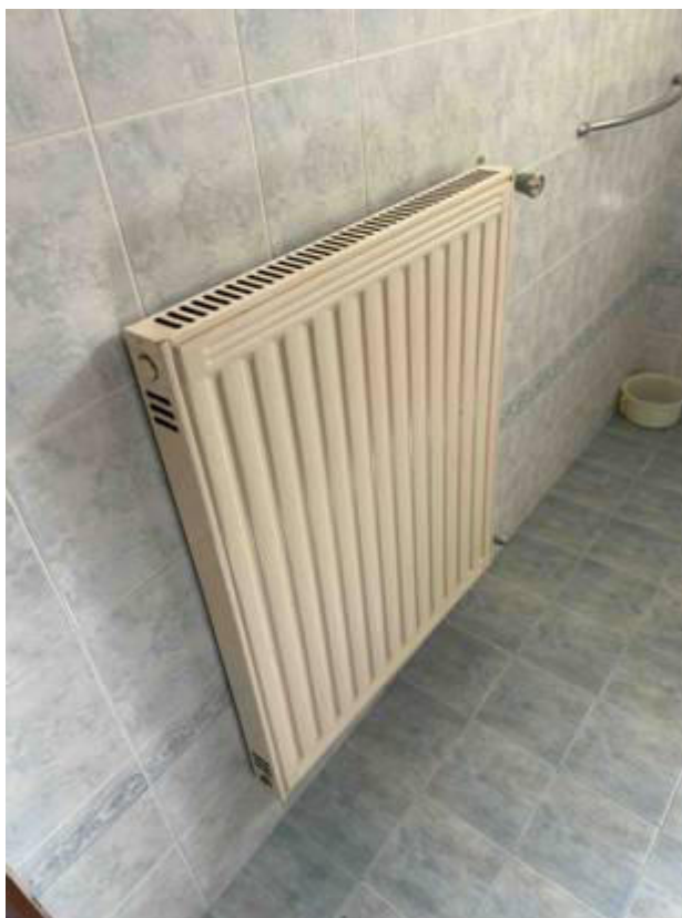
Foto n° 147 – Foto scattata al radiatore in alluminio pre-verniciato dell'impianto termico. L'impianto termico risulta sottotraccia ed a norma.
