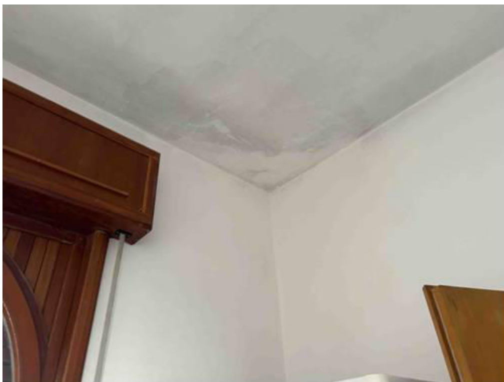
Foto n° 76 – Foto scattata al soffitto del bagno. Si rilevano tracce di umidità pregressa che risultavano provenienti dal lastrico solare.
