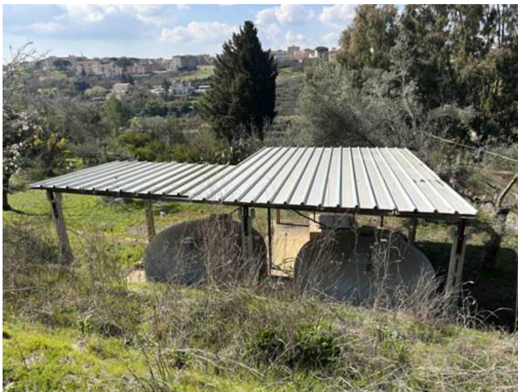
Foto n° 29 – Foto scattata nel terrazzamento sottostante in cui è presente una tettoia dove all'interno sono posizionati dei serbatoi in polietilene della capacità di 10.000 litri cadauno.
