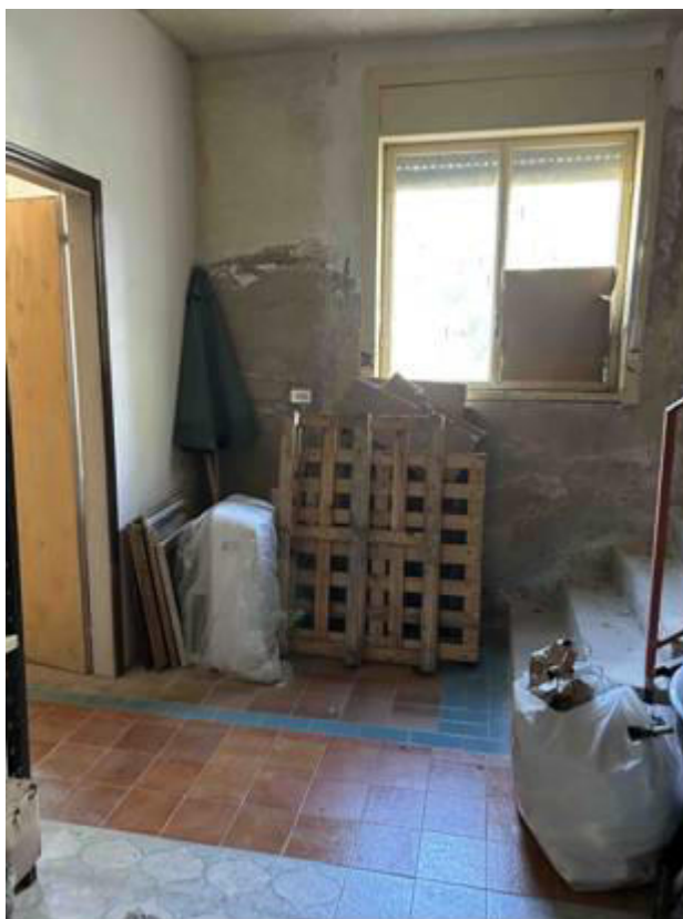
Foto n° 156 – Foto scattata alla pavimentazione ed alle pareti perimetrali. Si rilevano diverse tipologie di pavimentazioni (maiolica anni 70 e monocottura) e alcune porzioni delle pareti risultano intonacate ma non rifinite con tonachina.
