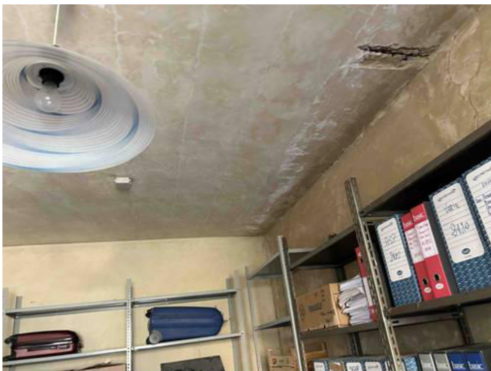
Foto n° 159 – Foto scattata nel soffitto del locale deposito rifinito con intonaco civile e tonachina. Si rilevano tracce di umidità pregressa che hanno determinato l’ossidazione dei ferri ed il distacco del copriferro.
