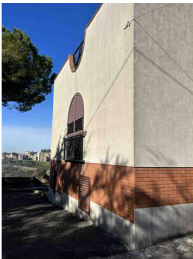
Foto n° 12 – Foto del prospetto laterale esposto a sud. La facciata è rivestita partendo da terra con lastre di pietra, da mattoni in clinker (nel piano sottostrada) e da intonaco civile e tonachina.
