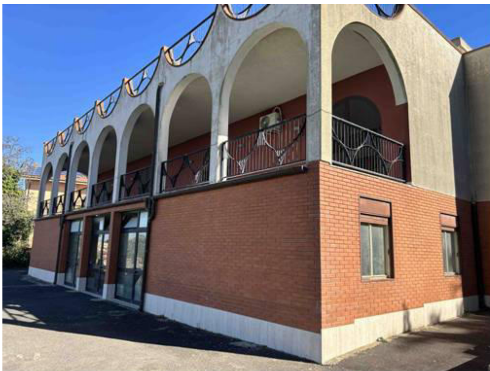
Foto n° 14 – Altra foto scattata al prospetto posteriore esposto a sud-ovest. La facciata è rivestita partendo da terra con lastre di pietra, da mattoni in clinker (nel piano sottostrada) e da intonaco civile e tonachina. Al primo piano si rileva un terrazzo delimitato da ringhiera e da soprastante solaio di copertura.
