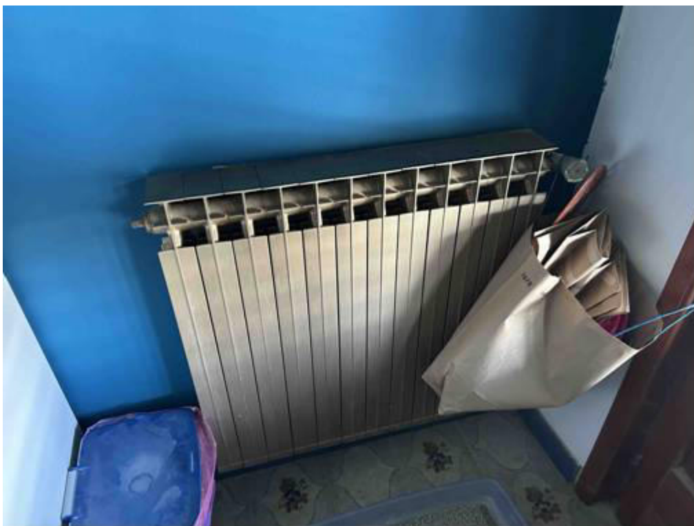
Foto n° 83 – Altra foto scattata al radiatore in alluminio pre-verniciato dell'impianto termico. L'impianto termico risulta sottotraccia ed a norma.
