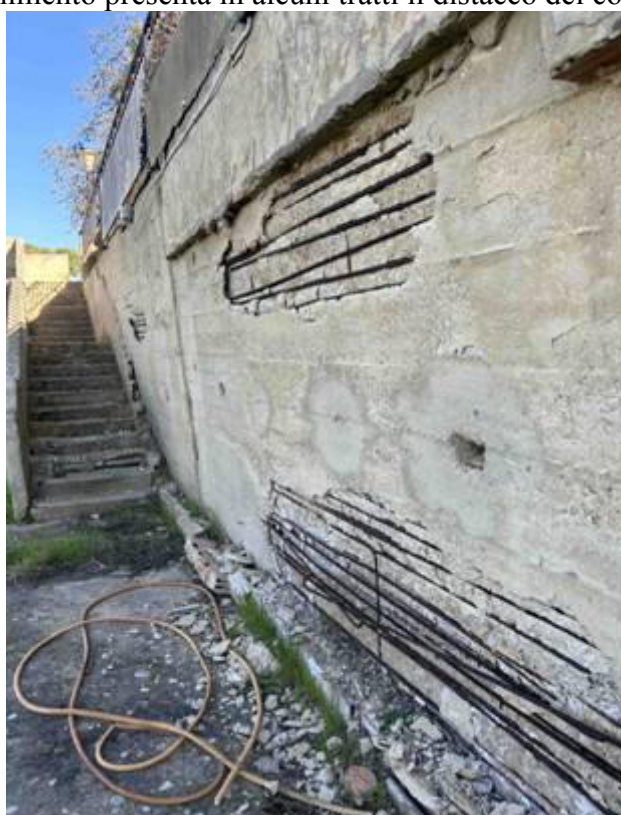
Foto n° 22 – Altra foto scattata al muro di contenimento. Lo stesso presenta solo l'armatura metallica in direzione longitudinale e non quella verticale. In atto vi è un cinematismo rotazionale della base dovuta alla soprastante spinta nella parte sommitale del muro, proveniente dal piano sottostrada.
