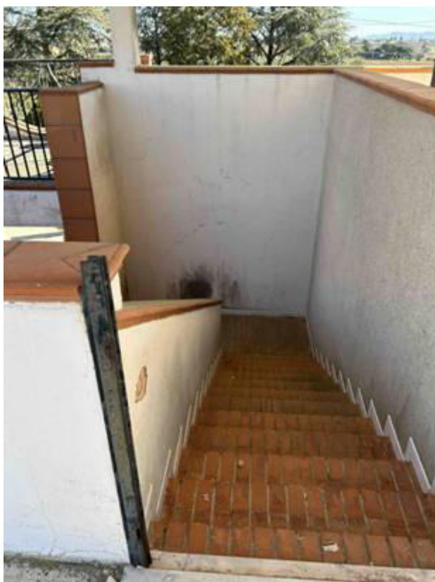
Foto n° 44 – Foto scattata alla scala che consente l'accesso al soprastante lastrico solare. Le pedate e le alzate della scala sono realizzate con mattoni in clinker. Le pareti esterne sono tutte intonacate e rifinite a tonachina.
