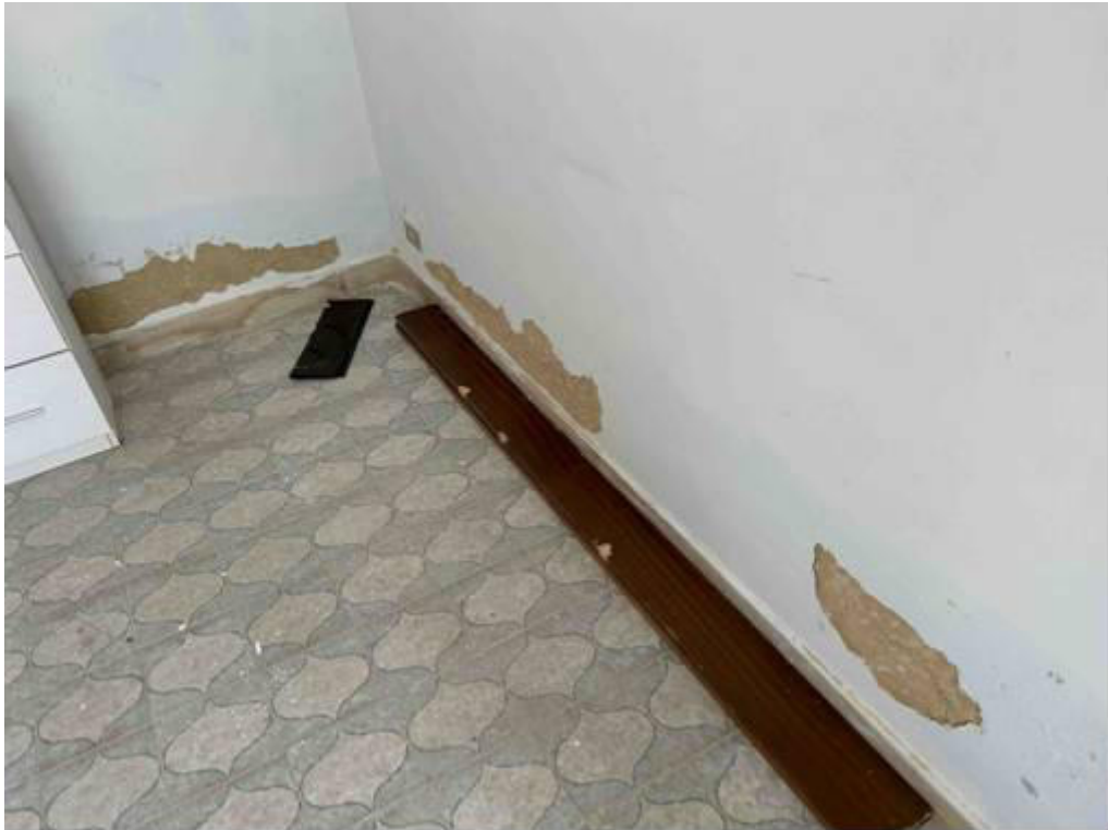
Foto n° 141 – Altra foto scattata alla pavimentazione ed alle pareti perimetrali. Si rilevano porzioni in cui è presente dell'umidità di risalita lungo le pareti perimetrali.
