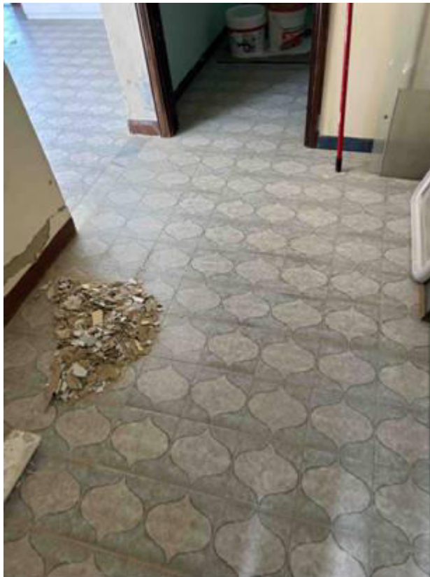
Foto n° 144 – Foto scattata alla pavimentazione in maiolica del disimpegno. Si rilevano lungo le pareti delle zone in cui è presente dell'umidità di risalita.
