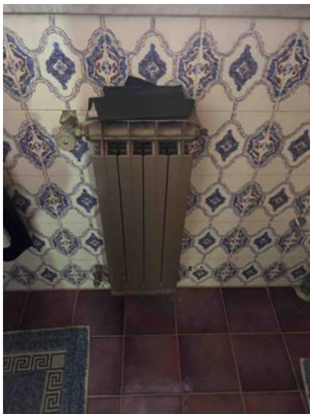
Foto n° 71 – Altra foto scattata al radiatore in alluminio pre-verniciato dell'impianto termico. L'impianto termico risulta sottotraccia ed a norma.
