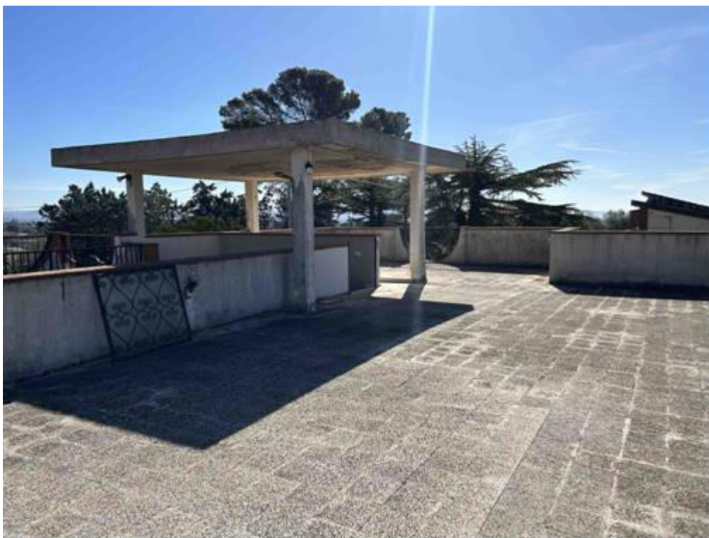
Foto n° 43 – Altra foto scattata al lastrico solare. La pavimentazione è in scaglie di granito. La scala di accesso ed un porzione del lastrico solare è ricoperto con un solaio che presenta problemi di infiltrazioni.
