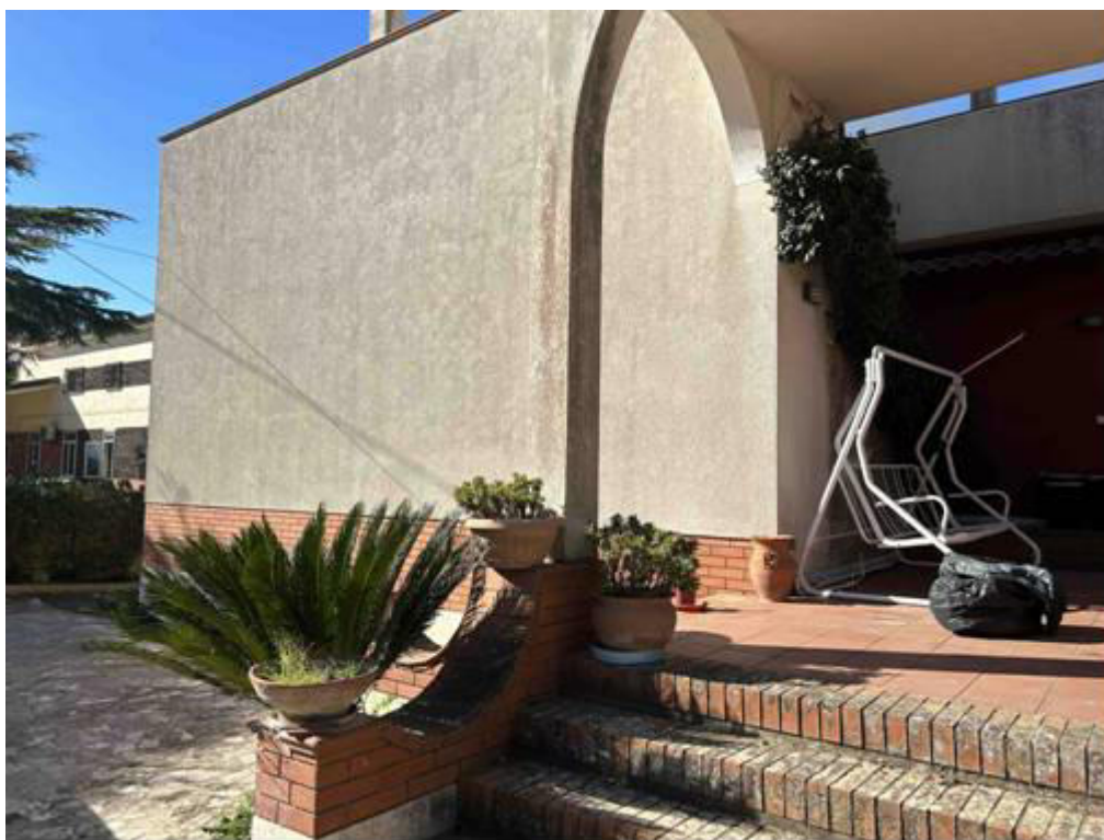
Foto n° 10 – Altra foto di una porzione del prospetto principale. L'intonaco esterno presenta segni di vetusta, risultando di una colorazione scura dovuta alla formazione di alghe, muffe e muschi.
