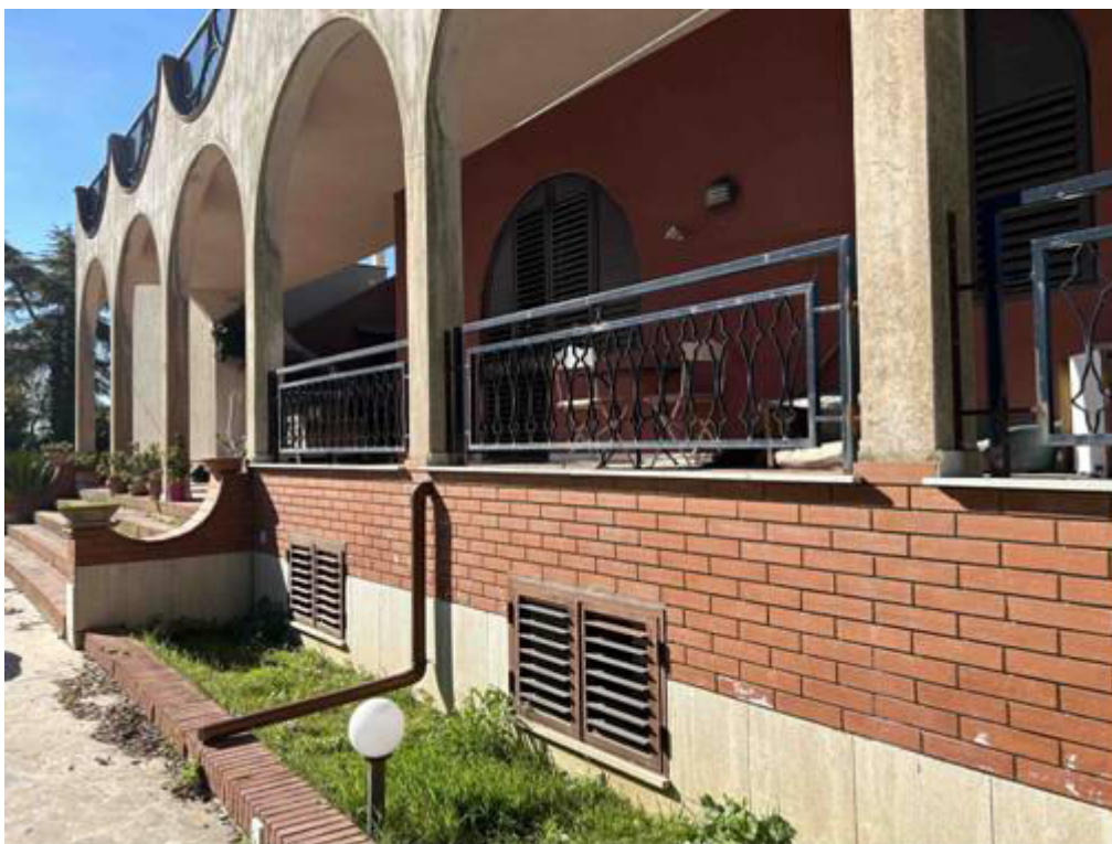
Foto n° 19 – Foto di una porzione del prospetto principale. L'intonaco esterno al piano rialzato presenta segni di vetusta, risultando di una colorazione scura dovuta alla formazione di alghe, muffe e muschi.
