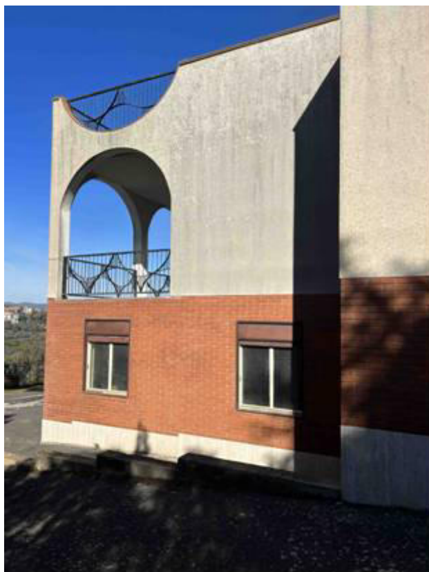
Foto n° 13 – Altra foto scattata al prospetto laterale esposto a sud. La facciata è rivestita partendo da terra con lastre di pietra, da mattoni in clinker (nel piano sottostrada) e da intonaco civile e tonachina.
