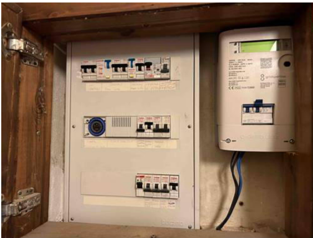
Foto n° 109 – Foto scattata al quadro elettrico generale. Lo stesso presenta due differenziali magneto-termici (salva-vita) con sezionati i piani e gli impianti elettrici esterni per l'irrigazione e l'illuminazione.
