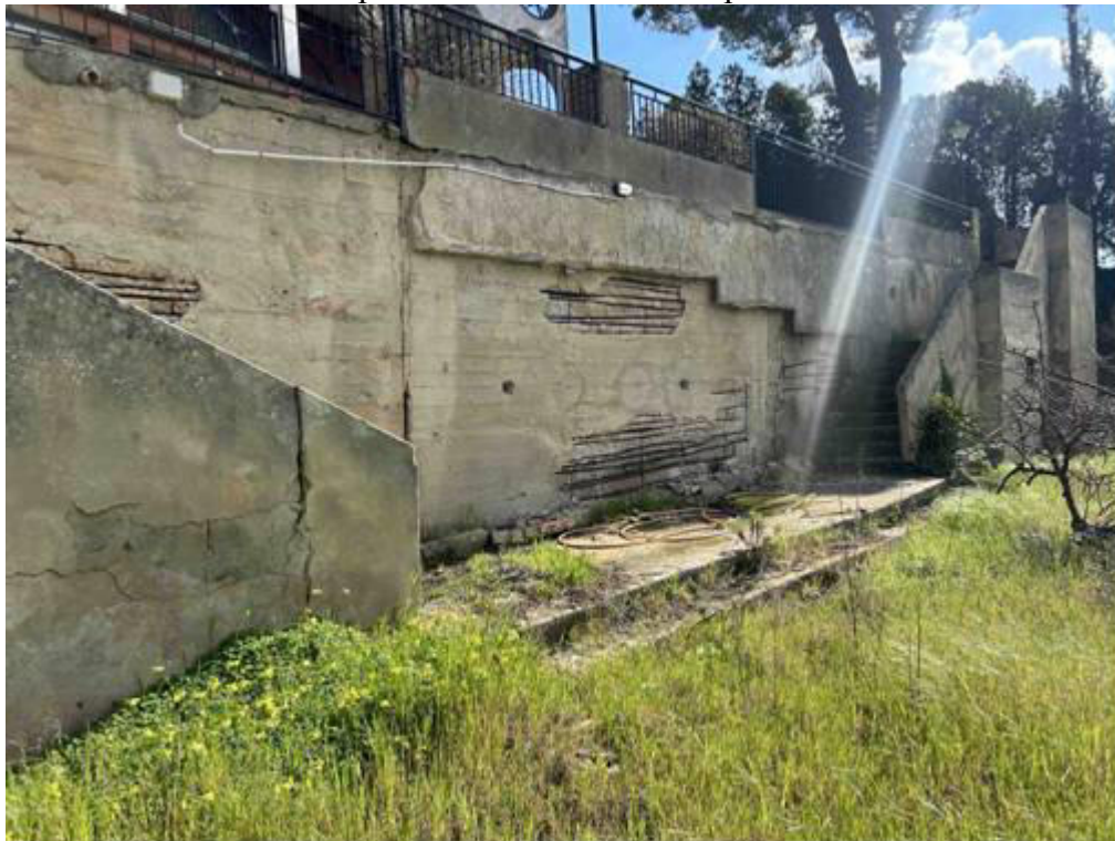
Foto n° 24 – Vista globale del muro di contenimento realizzato al di sotto del piano sottostrada. Si rileva il distacco del copriferro e la rotazione alla base dello stesso muro dovuta alla spinta soprastante nella parte sommitale, proveniente dal piano sottostrada. Lesioni estese nei parapetti in muratura della scala.
