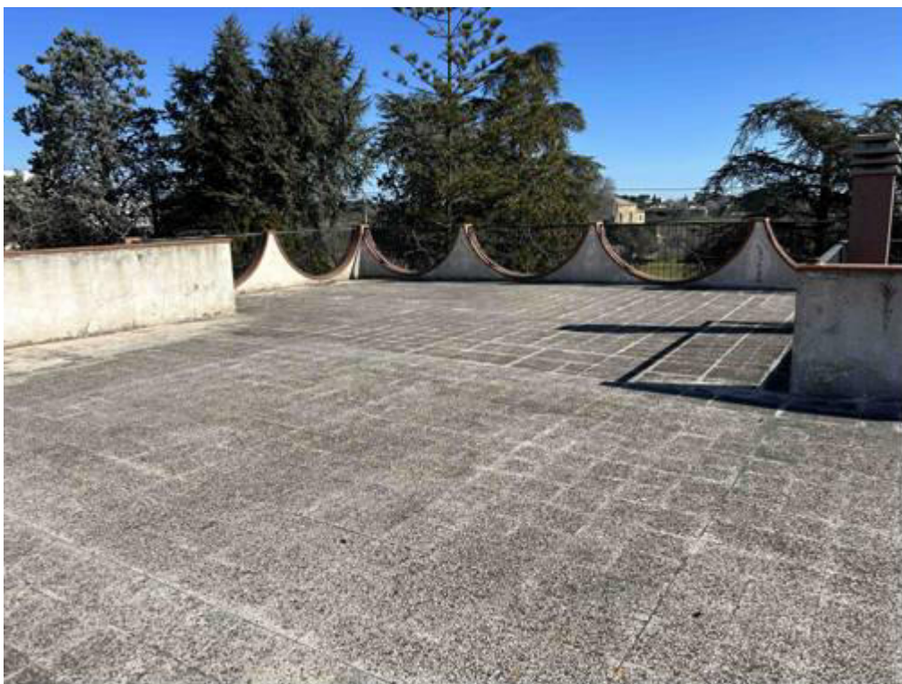
Foto n° 41 – Altra foto scattata al lastrico solare. La pavimentazione è in scaglie di granito mentre il parapetto è costituito da muratura intonacata e da ringhiera in ferro pieno. La parte sommitale ed inferiore del parapetto in cui poggia la ringhiera è rivestita con mattoni in clinker.
