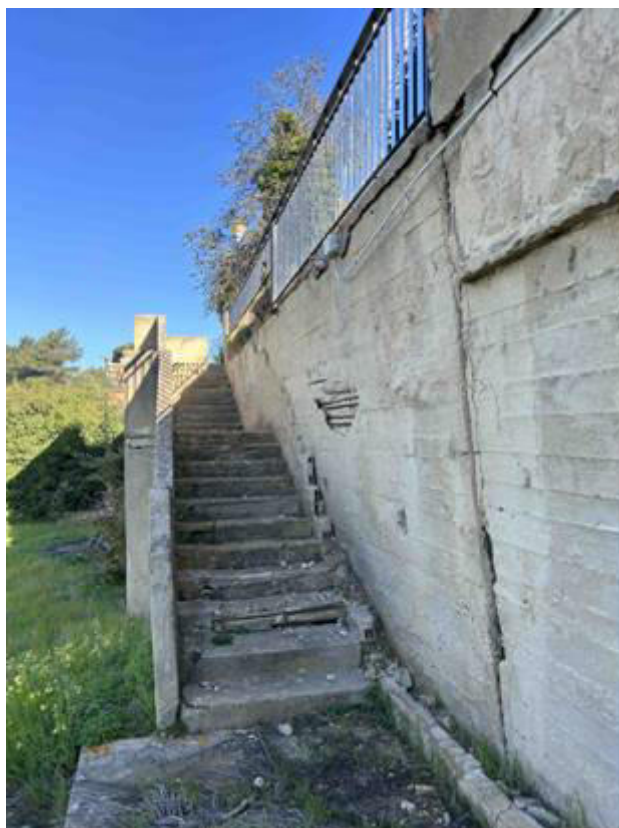
Foto n° 23 – Altra foto scattata alla scala in cemento armato che consente l'accesso sia alla porzione di terreno posta al di sotto che al piano sottostrada. Il muro di contenimento presenta il distacco del copriferro.
