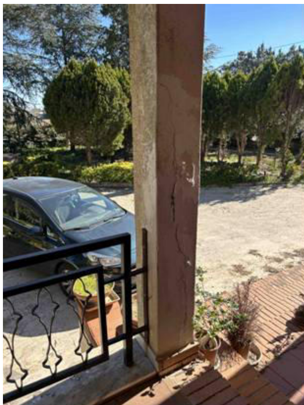
Foto n° 49 – Foto scattata in uno dei pilastri del portico. Si rileva una lesione verticale che dal piano di calpestio arriva fino a metà pilastro ed imputabile all'ossidazione del copriferro.
