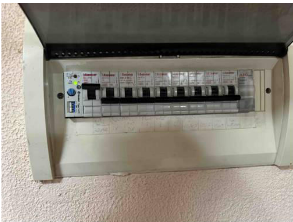
Foto n° 58 – Altra foto scattata al quadro elettrico. Lo stesso presenta il differenziale magneto-termico (salva-vita) con sezionati gli impianti elettrici esterni.
