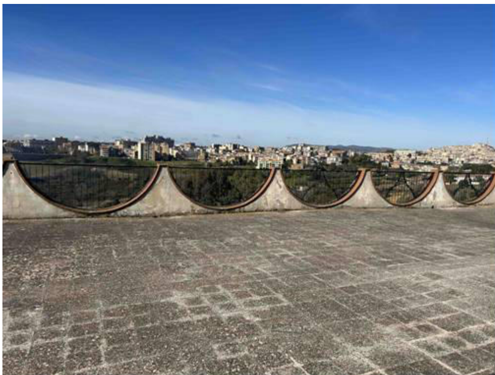
Foto n° 39 – Altra foto scattata al lastrico solare. La pavimentazione è in scaglie di granito mentre il parapetto è costituito da muratura intonacata e da ringhiera in ferro pieno. La parte sommitale ed inferiore del parapetto in cui poggia la ringhiera è rivestita con mattoni in clinker.
