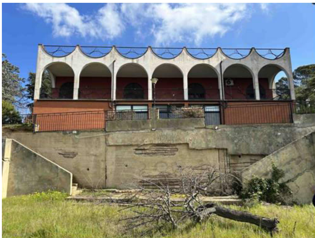
Foto n° 26 – Vista globale del muro di contenimento realizzato al di sotto del piano sottostrada. Si rileva il distacco del copriferro e la rotazione alla base dello stesso muro dovuta alla spinta soprastante nella parte sommitale, proveniente dal piano sottostrada.
