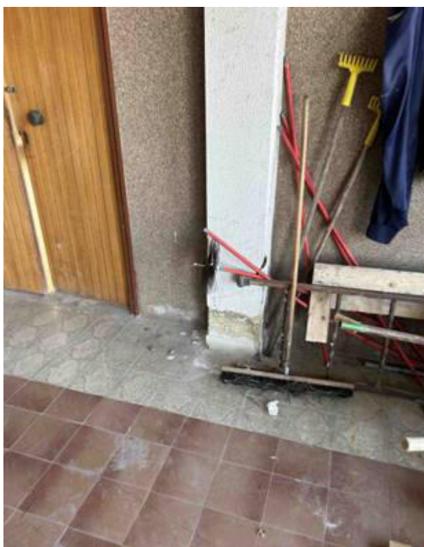
Foto n° 154 – Altra foto scattata ad uno dei pilastri del portico. Si rilevano tracce di umidità di risalita lungo il pilastro. L'umidità ha sicuramente determinato l'ossidazione del ferro e determinerà anche il distacco del copriferro.
